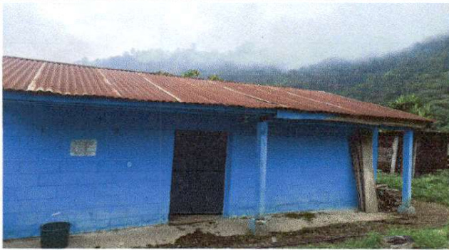
Foto 1: Sustitución de lamina, por lamina troquelada aluzinc calubre 26
