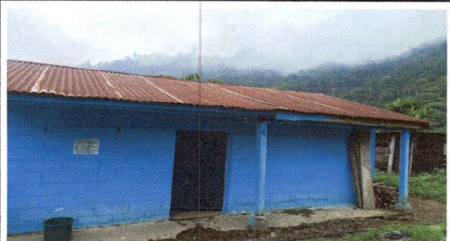
Foto 4: Sustitucion de piso de torta de cemento
