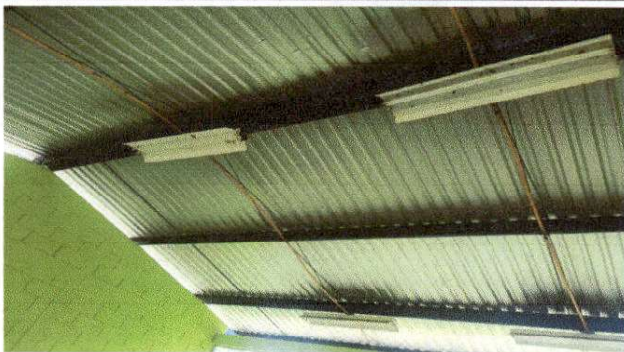
Foto 3: Reparación del sistema electrico
